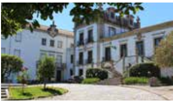
Casa da Torre (Soutelo)
